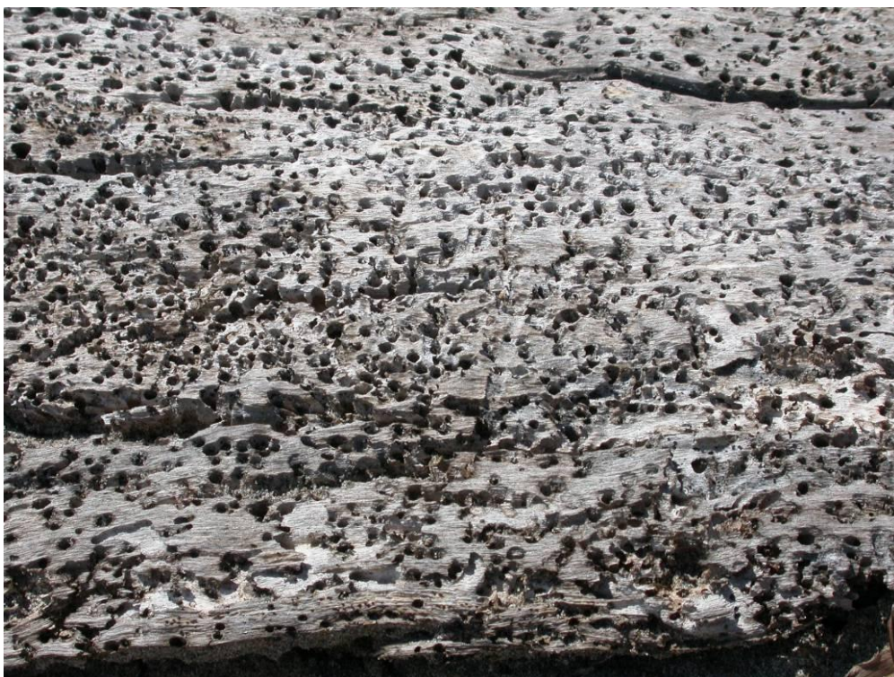
Figura 5.3 – Dettaglio della foto precedente da cui è possibile apprezzare la densità delle gallerie scavate dagli insetti
