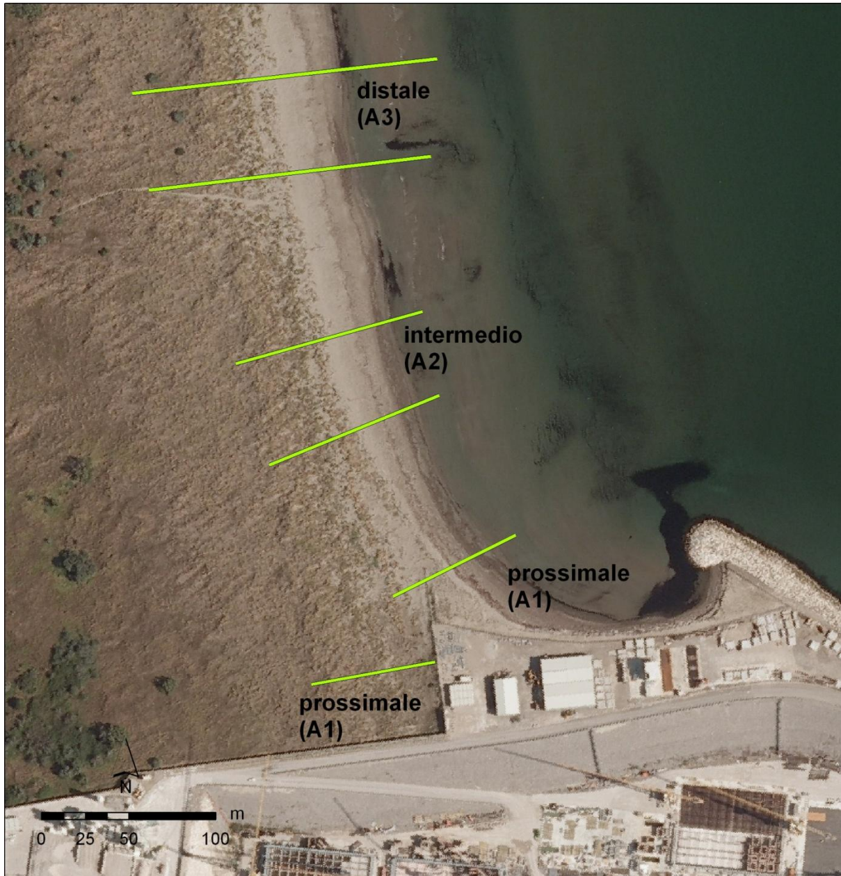
Figura 2.3 - Sito di Ca' Roman, con evidenziati i tre settori per le indagini quali-quantitative. Foto volo SELC, 2010.
