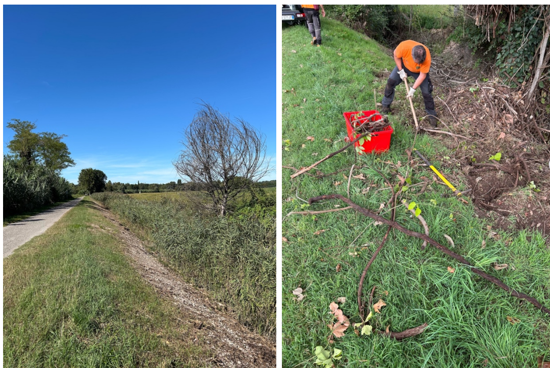
Figura 6 Due immagini del sito: a seguito del primo intervento di rimozione della biomassa, sinistra, e del secondo intervento di rimozione dei nodi radicali, destra (foto: M. Buson).
