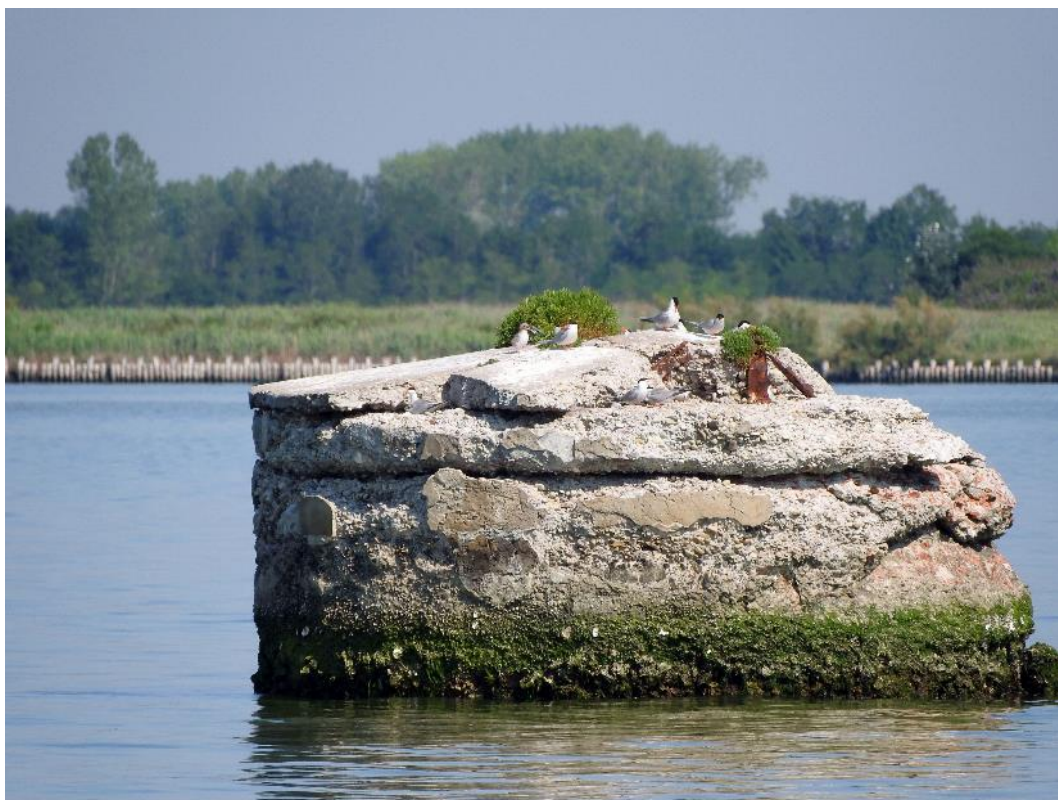
Fig. 2.6. Sterne comuni nidificanti su plinti in calcestruzzo nei pressi dell'isola di Carbonera (Foto F. Scarton).
