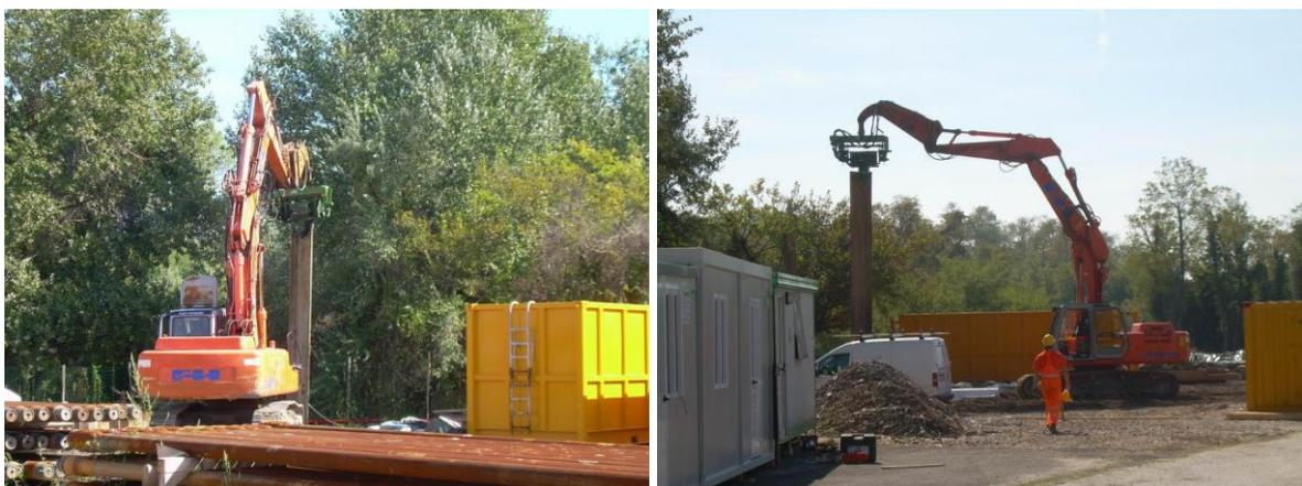
Figura 2.7. Foto dell'attività nel cantiere del cavidotto caratterizzata dall'infissione nel terreno di palancole metalliche, scattate in data 01/10/2007 – campagna di monitoraggio autunnale
