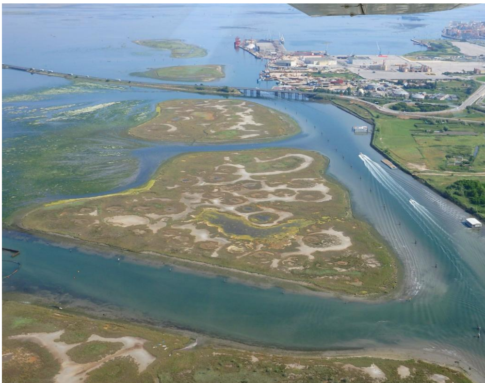
Fig. 4.4. Veduta aerea delle barene artificiali Chioggia B2 e Chioggia B3 (Foto: I. Cavalli).
